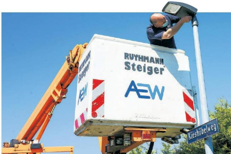
Die LED-Leuchten werden hell, wenn die Radarsensoren eine Person, ein Auto oder ein Fahrrad erfassen. Foto: Edi Strub
